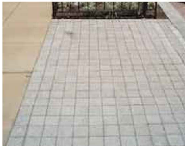
4 COBBLE PRECAST PAVERS N.T.S.
